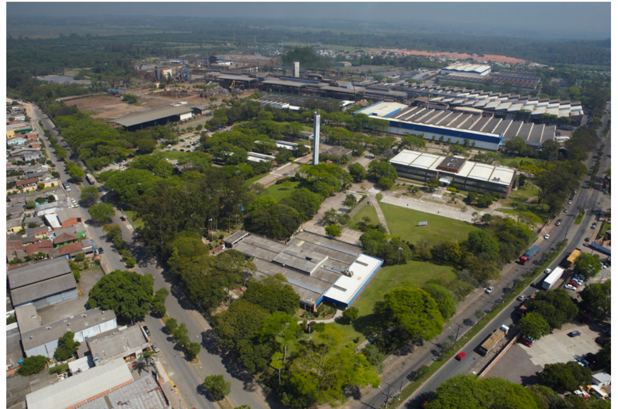
Planta Gerdau Riograndense, Sapucaia do Sul (Estado de Rio Grande do Sul)
