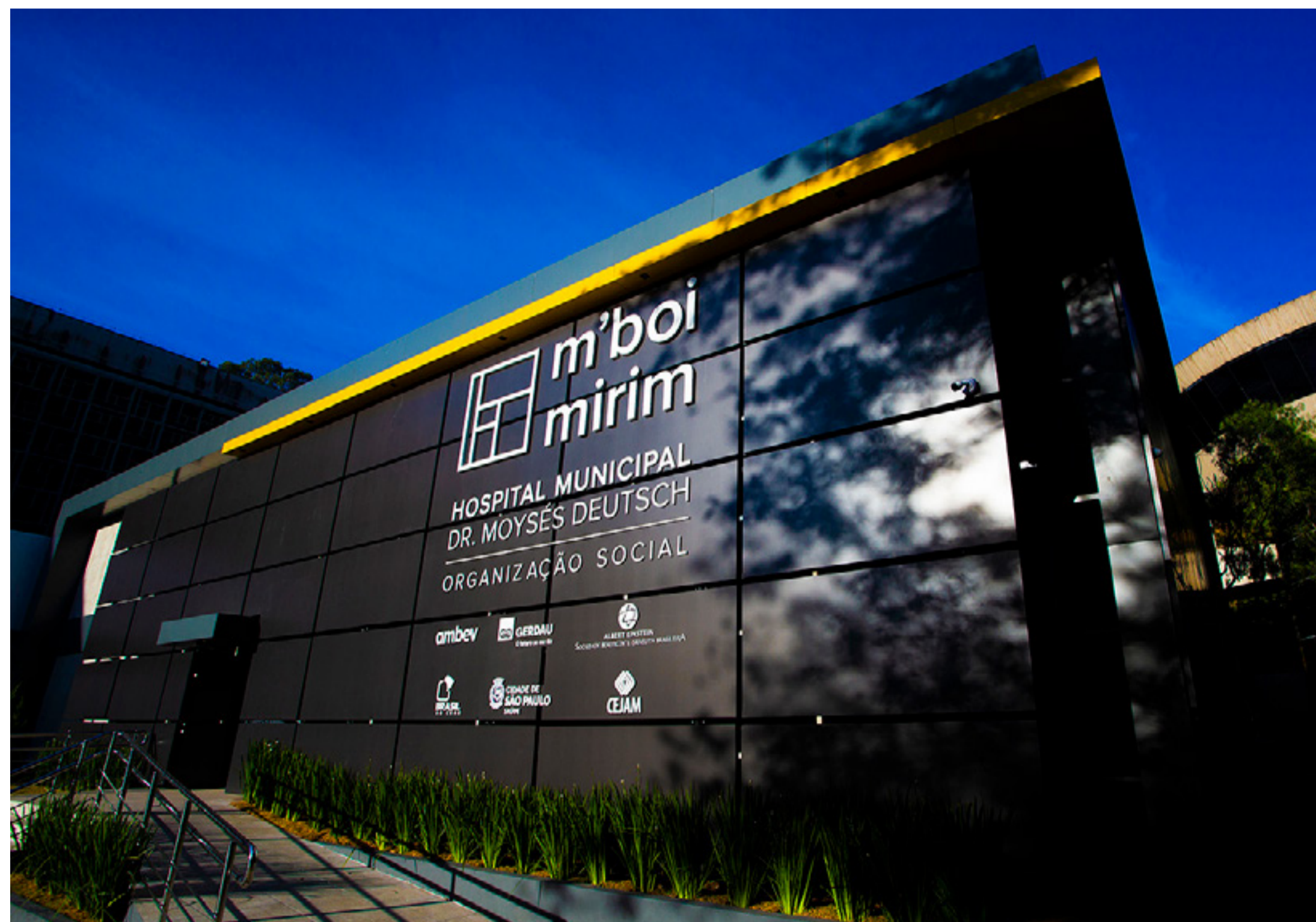
Centro de Tratamiento de la Covid-19, en São Paulo (Estado de São Paulo), construido con recursos de Gerdau y empresas aliadas
